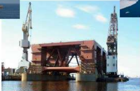
Изготовление двух опорных оснований полупогружной платформы MOSS CS-50, 2007-2009 Основные размеры: 118×70×40 м, вес около 15 тыс. тонн
